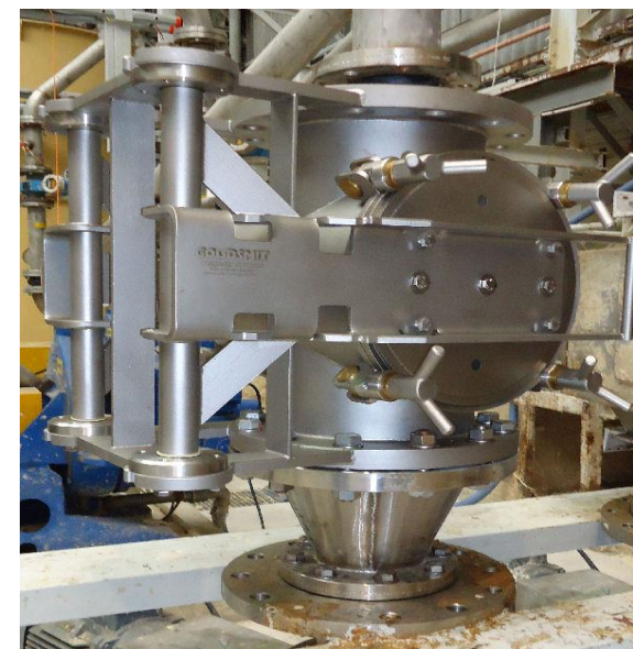
Magnetyczny system separacji podczas pracy
